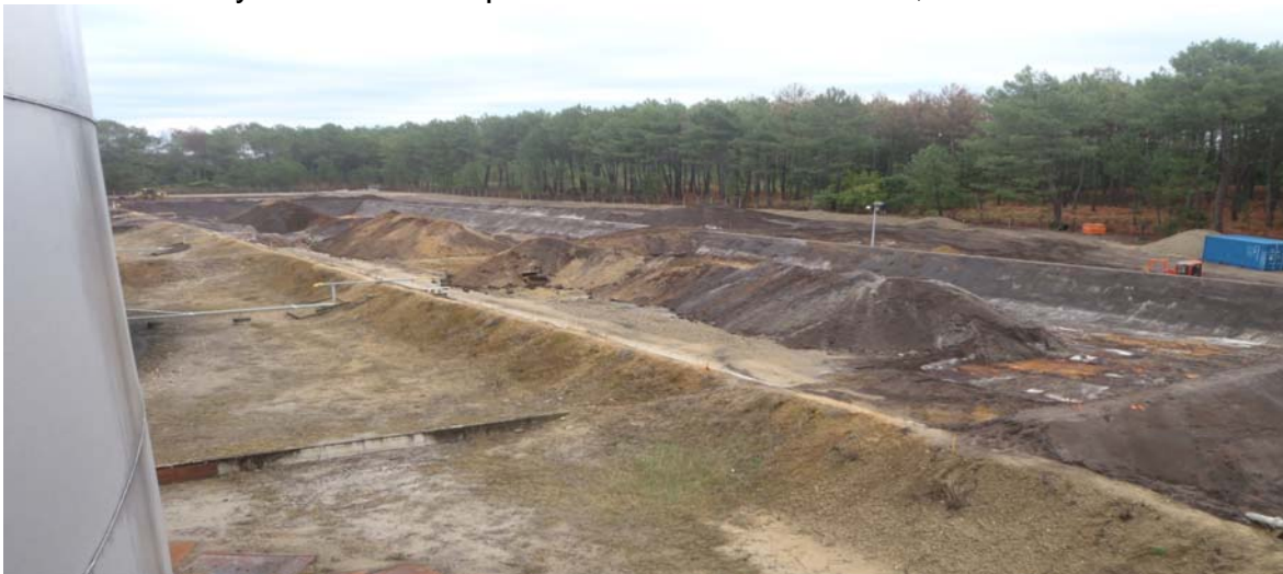
DEPOT PETROLIER DE MONT DE MARSAN
