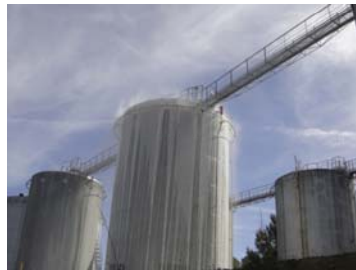
DEPOT PETROLIER DE MONT DE MARSAN
